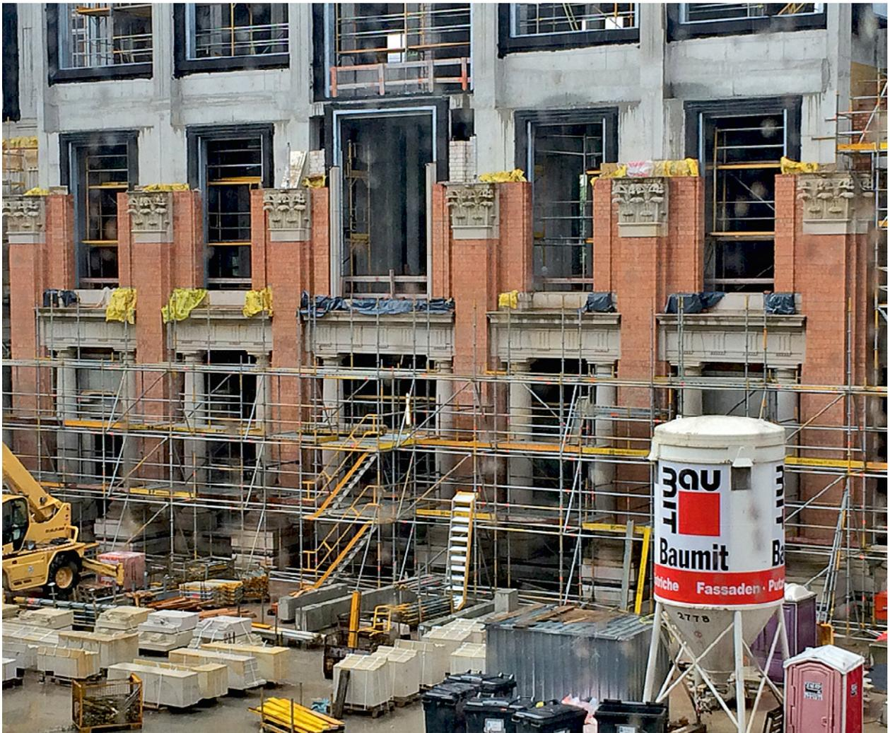
Alles Handarbeit: 3,5 Millionen Ziegel werden vermauert, hier das Mauerwerk mit den Pilastern im Portal VI im Schlüterhof.
